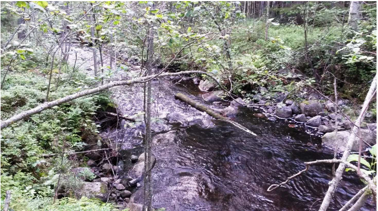
Kuva 24. Sokojoesta Pieliseen laskevassa Rännipurossa on uiton aikaisia rakenteita (kuva: Mirko Laakkonen)
