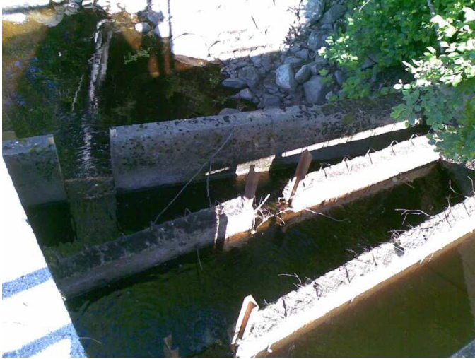
Kuva 7. Saramojoella sijaitsevan Louhikosken toimimaton "kalaporras" ylävirran suunnasta kuvattuna (kuva: Mirko Laakkonen)
